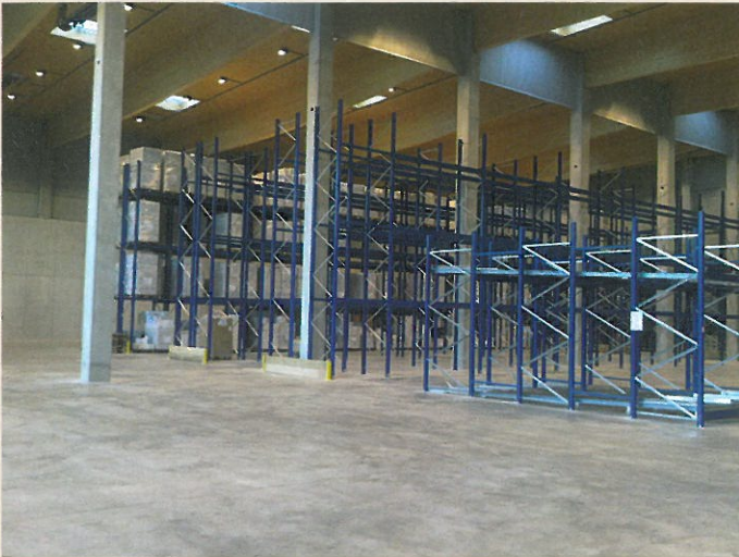
Abb. 2 Lagertechnik: Regale und Rollbahnen
