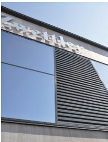
Das Lamellenwandsystem besteht aus stranggepressten Aluminium-Profilen.
